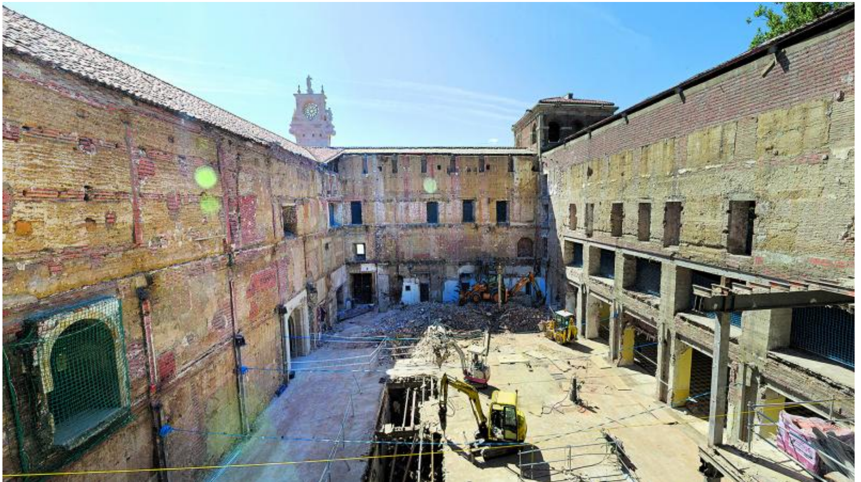
El edificio recupera su patio. El vaciado de la parte central del edificio histórico, que data de 1964, permitirá recuperar un espacio del siglo XVIII. :: MAURICIO PEÑA
